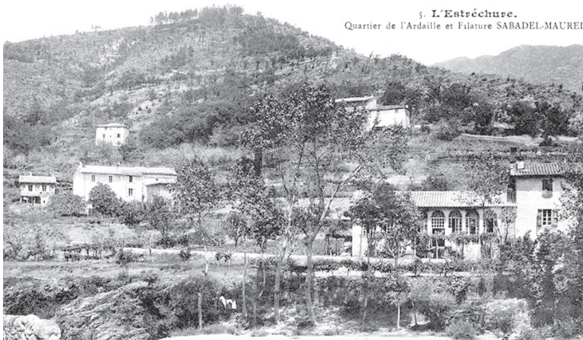
La filature Sabadel-Maurel, quartier de l'Ardaillier à Saumane, construite sur deux niveaux. Une maison de maître est accolée à la filature.
